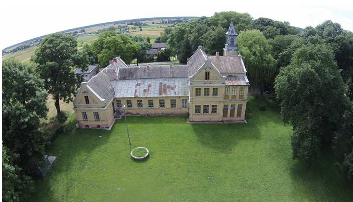
Fot.7 Pałac w Branicy Radzyńskiej.
