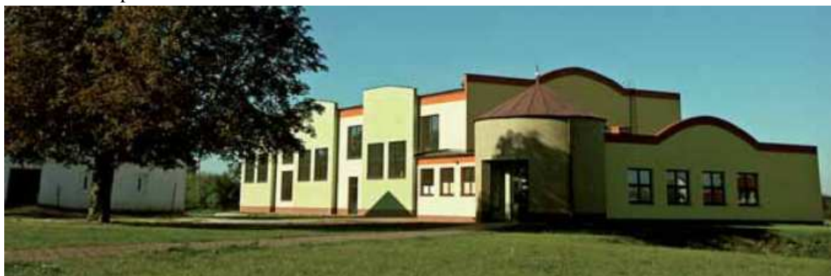
Fot. 15 Hala sportowa w Żabikowie.
