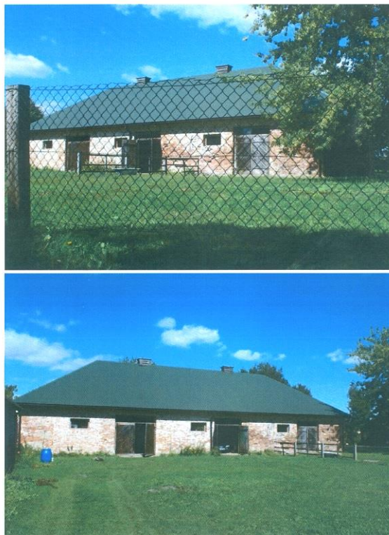
Zdj. 14. Wozownia i stajnia (rej. zabytków)
