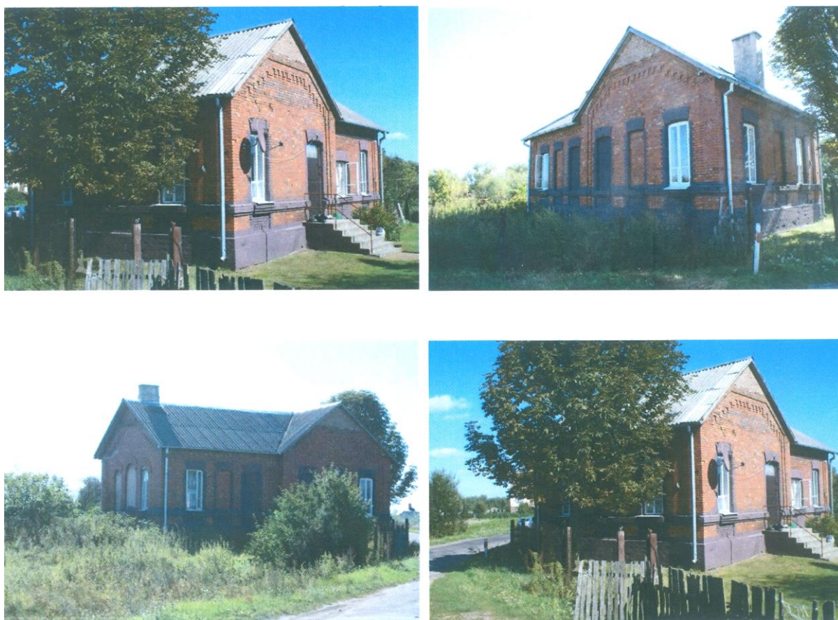
Zdj. 34. Przepompownia wody PKP, koszarka PKO (źródło: karta ewidencyjna)
